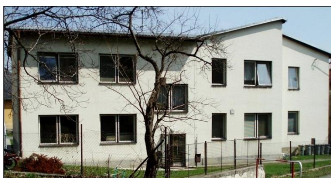
Budova B Slunečná 2/173
