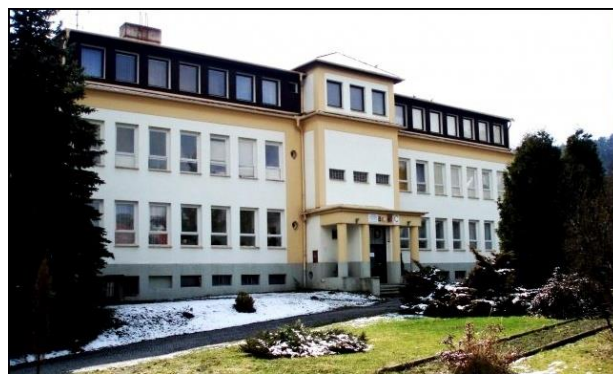
Budova C Sokolovská 1/647
